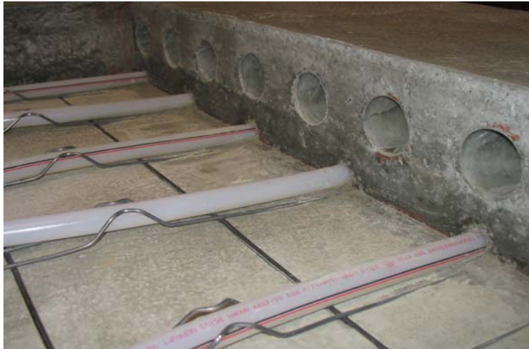
Fig. 2: Detail doorsnede thermisch actief vloerelement
