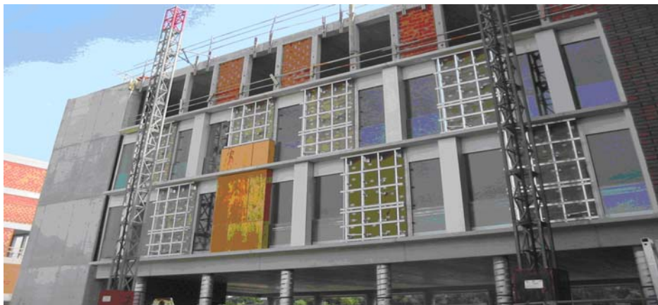
Fig. 1: Ontwerpsimulatie met repetitie in de gevel opgebouwd uit TT-elementen en snelbouwinvulling
