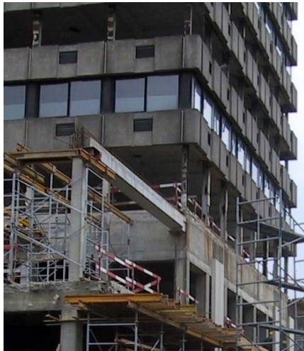
Gebouw bij aanvang renovatie
