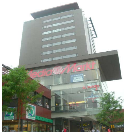
Situatie na recente renovatie
