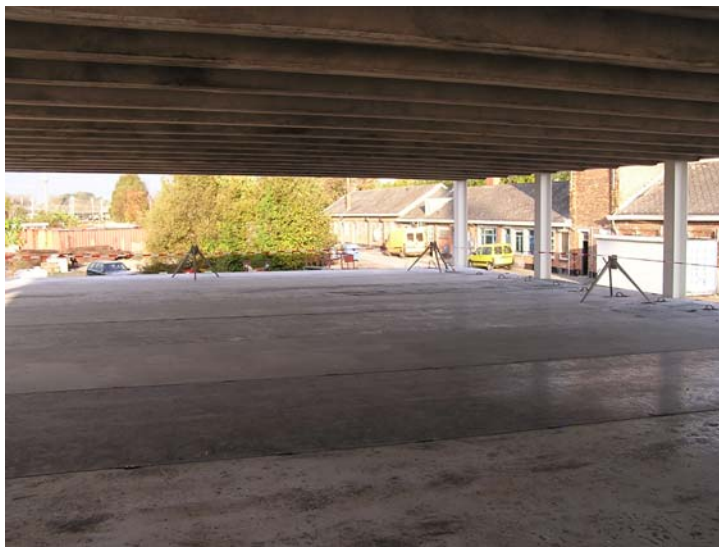
Algemeen zicht op de eerste verdieping van een deel van de parking. De oppervlakte van de TTP-platen zijn glad afgewerkt.
