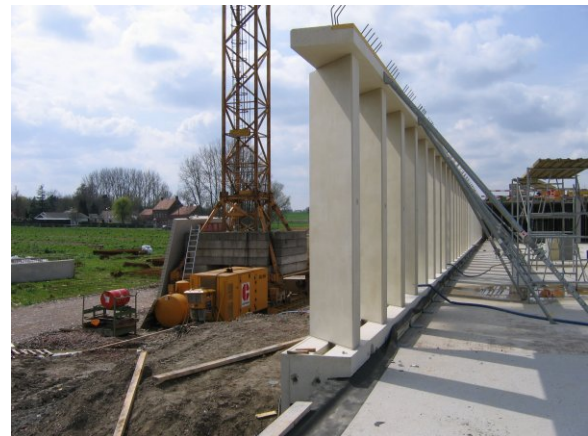
Afbeelding 6: Montage van gevelelementen
