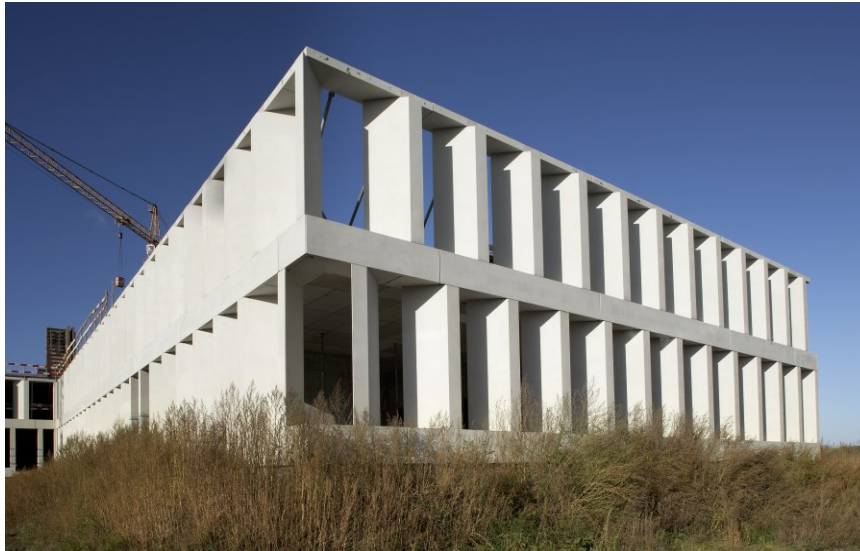
Afbeelding 4: Gevelstructuur in prefab beton
