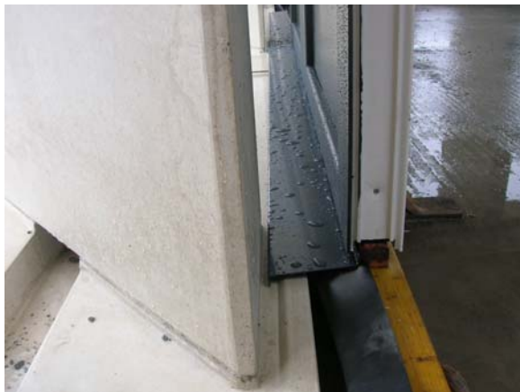
Afbeelding 5: Detail raam-aansluiting onderaan
